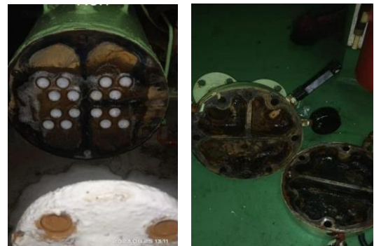
Gambar 5. Cleaned condensor dan cover condensor. Sumber: Dokumentasi pribadi.
