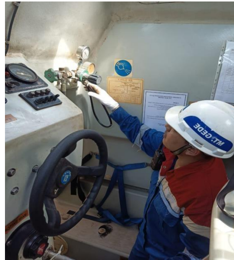
Gambar 2. Pengecekan tekanan pada tabung udara silinder.
