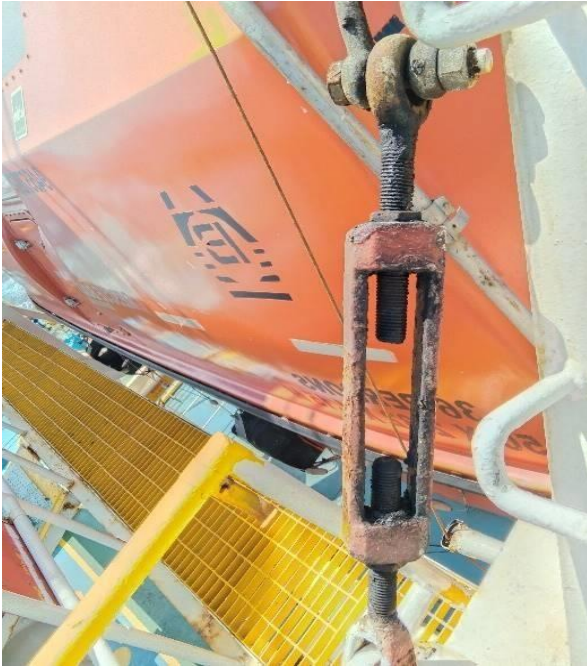
Gambar 7. Turnbuckle tidak di-grease.
