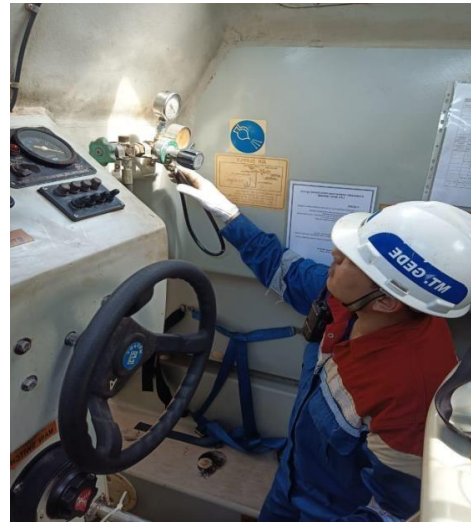
Gambar 2. Pengecekan tekanan pada tabung udara silinder.
